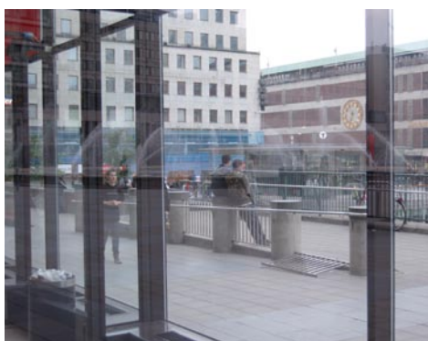
Glasvägg från insidan
