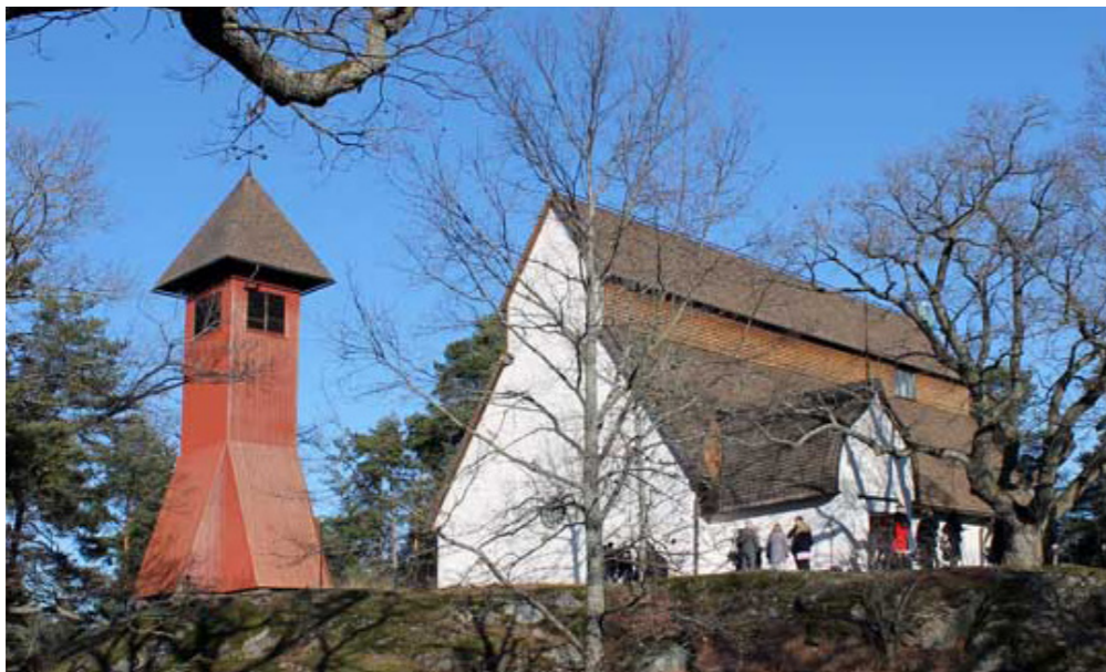
Kristinahuset och kyrkan i Stora Sköndal är befintliga byggnader som ska bevaras.
