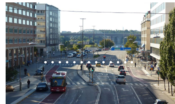
Fler vägval från Hornstulls torg efter ombyggnad och med nytt övergångsställe
