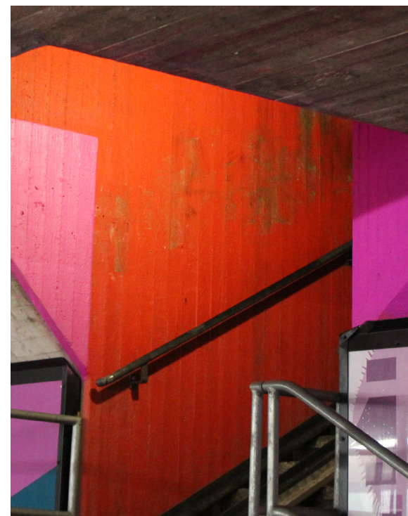
BELYST OCH FÄRGSATT TRAPPA I NOORSKENS TUNNEL
