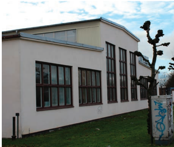
BILD. VERKSAMHETSBYGGNAD INOM TETRAPAK-OMRÅDET.
