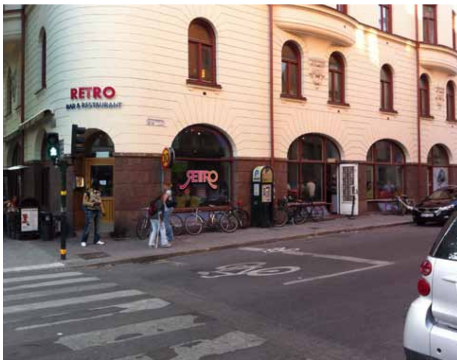
Figur. Cykelbox för cyklist som väntar på grönt ljus i signalreglerad korsning. Den upphöjda övergången har hastighetsdämpande effekt på den motoriserade trafiken.
