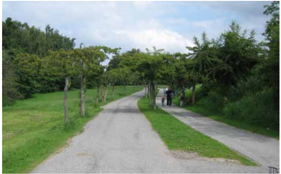
Figur. Separering i form av grön remsa, exempel från Danmark.
