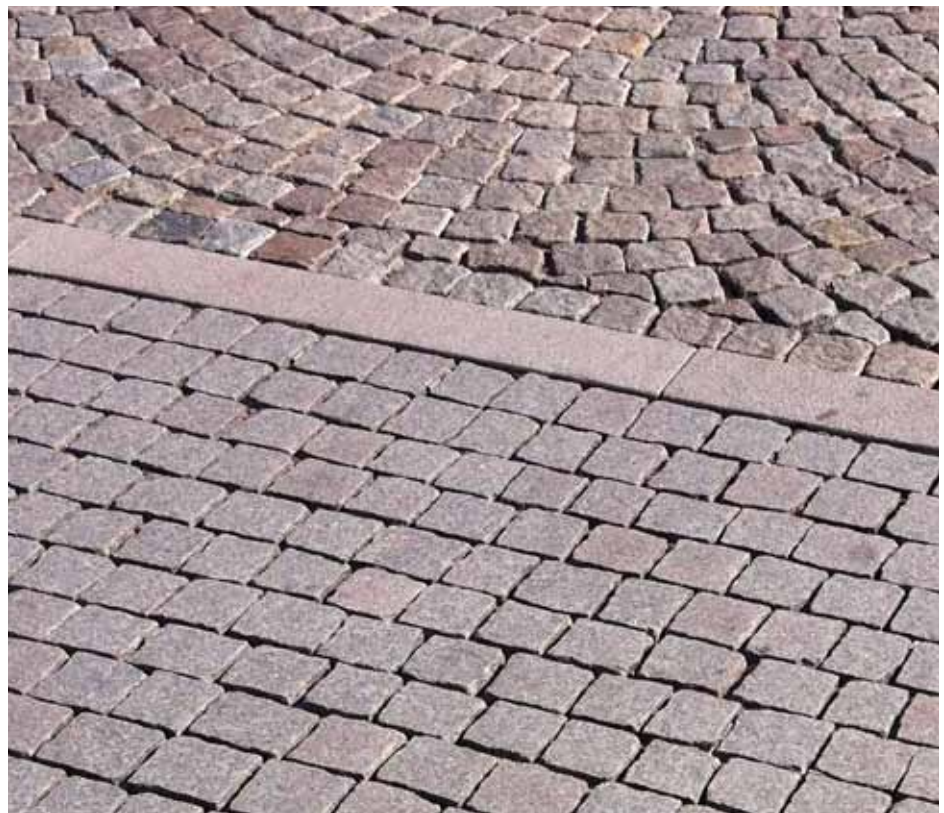
Figur. Ett band med sågad gatsten, eller hällar, gör att stenbeläggningen kan göras slät och komfortabel för cyklister i vackra stadsmiljöer. Fotgängare måste dock ha en minst lika slät beläggning, annars hamnar de i vägen för cyklisterna.
