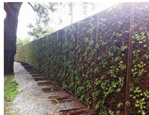
Exempel på grön bullerskärm. Bildkälla: http://www.bullernatverket.se/wp-content/uploads/2014/10/Gr%C3%B6n-Bullersk%C3%A4rm-660x507.gif .
