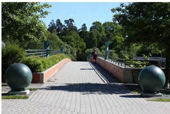
Haga Norra gångbro utgör entré till Hagaparken från Solna.
