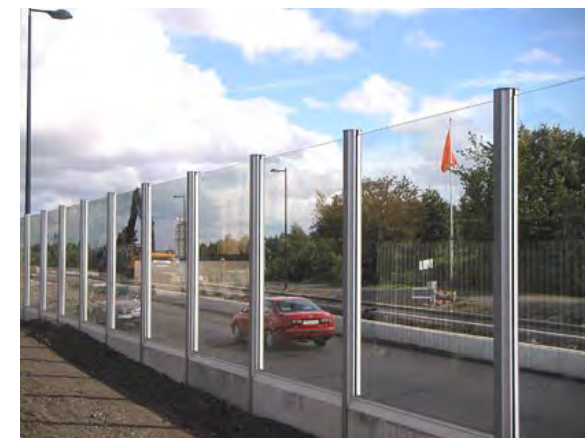
Exempel på genomsiktig bullerskärm. Bildkälla: http://web.telia.com/~u41803054/BILDER/produktbilder/vastan2.jpg .
