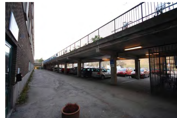
Upphöjd gång- och cykelbana framför Högsätrahuset.
