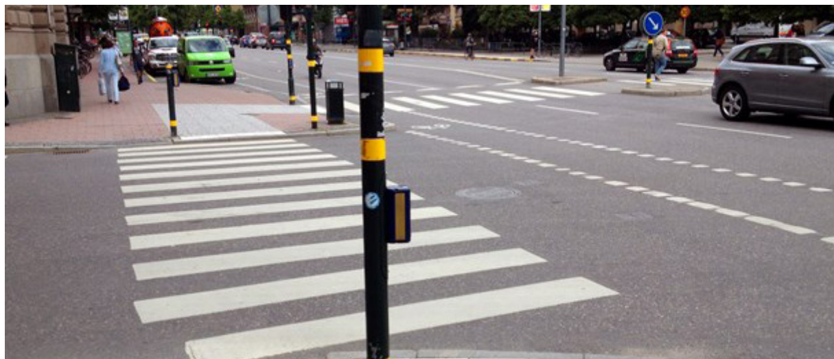
Signalreglerad korsning enligt Stockholmsmodellen med nedsänkt kantsten.
