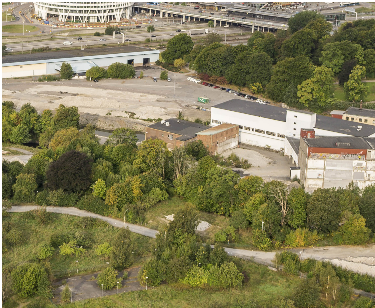
BYGGBAR MARK I FORSÅKER MED OLIKA GRADER AV RIVNINGSBEHOV
