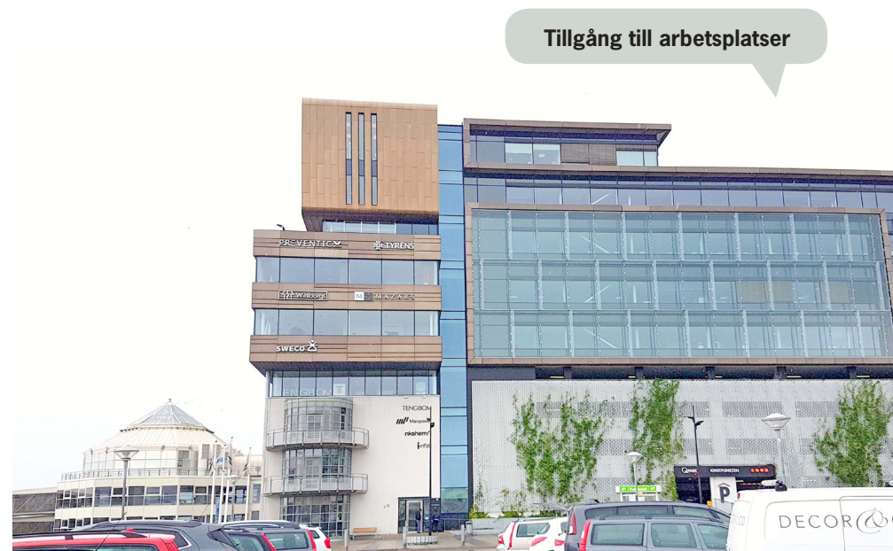
Bild 31. Kontorsbyggnad i Helsingborg
