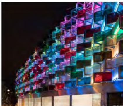
Mobilitetshubb Flustret, Vallastaden Linköping Cykelpool, parkering, bilpool, solceller, transformatorstation och bredbandsnod, sopsugs-terminal, miljörum/återvinningsstation, biltvätt, biodling, grön vägg, butikslokal, utlämningsstation, hyrcykelsystem för elcyklar.
