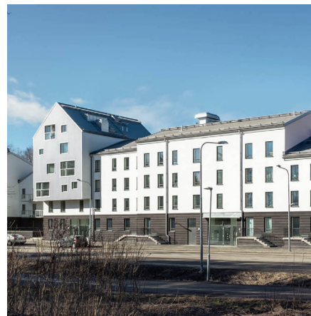
TVÄRSTÄLLDA GAVLAR MÖTER SADELTAK (ROSENDAL, UPPSALA)
