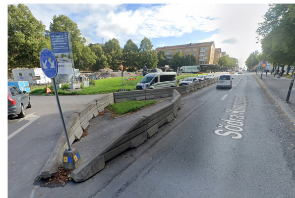
TEMPORÄRT TEST AV NY KORSNING MED TA-BALKAR
